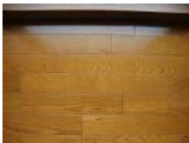
フローリングの紫外線による劣化
